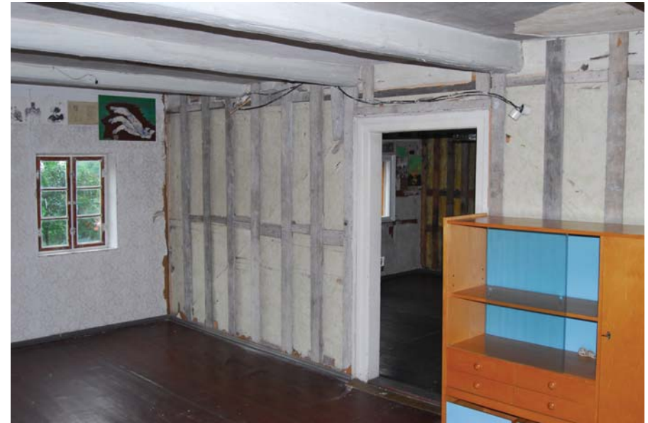
Die Zimmer im Obergeschoss – Zustand vor der Sanierung
